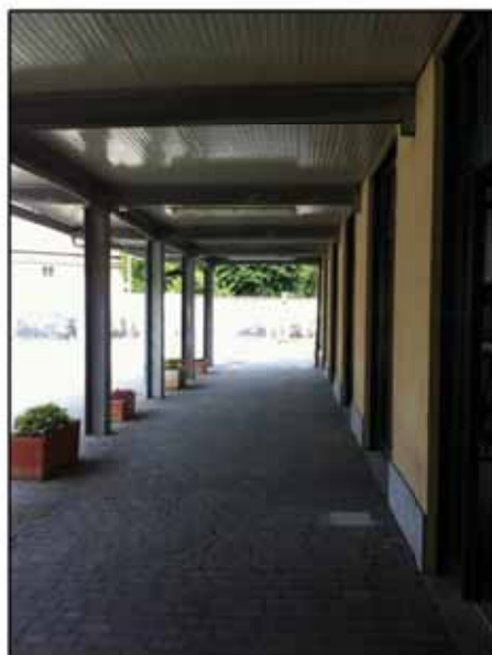
Vista interna del porticato
